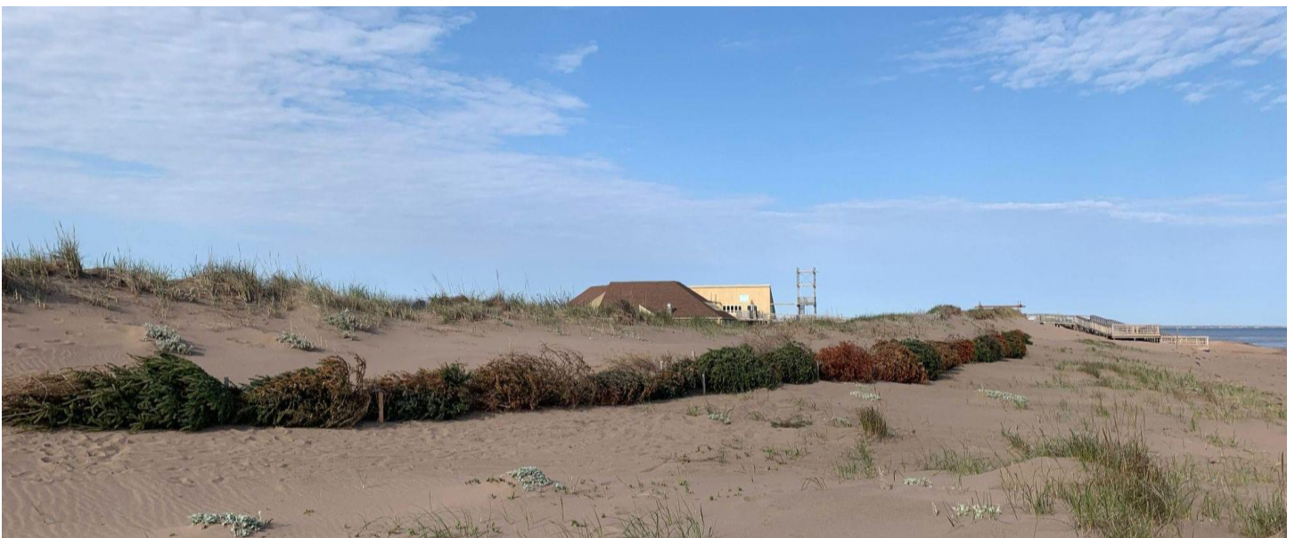
Figure 3: Sapins installés à la plage Aboiteau qui aident à accumuler le sable dans le but d'élargir la dune.
