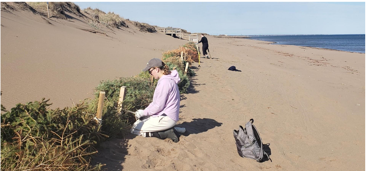
Figure 10: Installation de sapins pour accumuler le sable à la plage Sandy et Aboiteau (2025).
