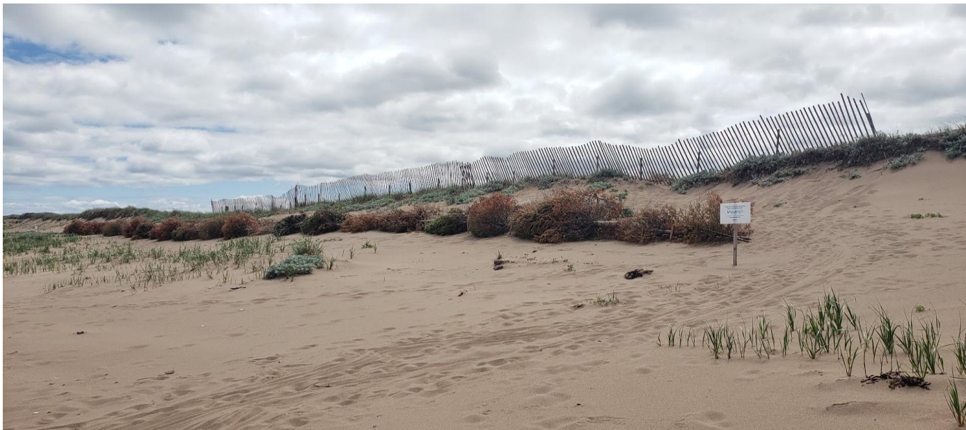
Figure 13: Protection à la plage Aboiteau, N.-B. (2025). Installation de barrières de sapins fixées pour accumuler le sable et de clôtures pour protéger les dunes du piétinement.
