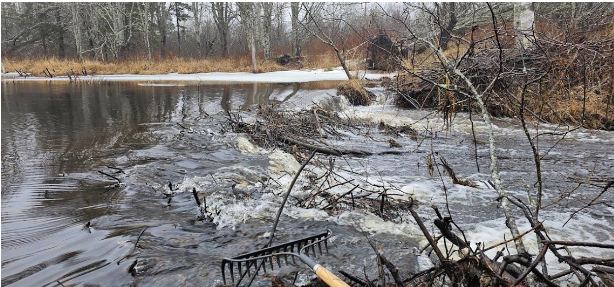
Figure 10 : Travaux manuel pour un passage partiel sur la rivière Gaspereau.
