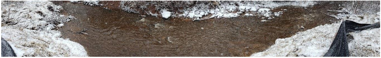
Figure 8 : Après le nettoyage du ruisseau Copp, Shemogue le 12 mars 2024. Enlèvement des blocs de béton bloquant un cours d'eau qui provenaient d'un ancien pont abandonné et préparation du site de restauration pour la plantation.
