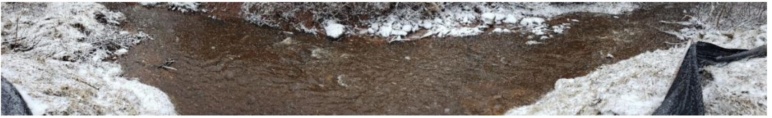
Fin des travaux et le cours d'eau à son état naturel.
